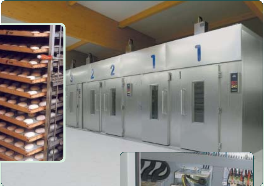
Frequenzgeregelter Kältemaschine für Backwaren
