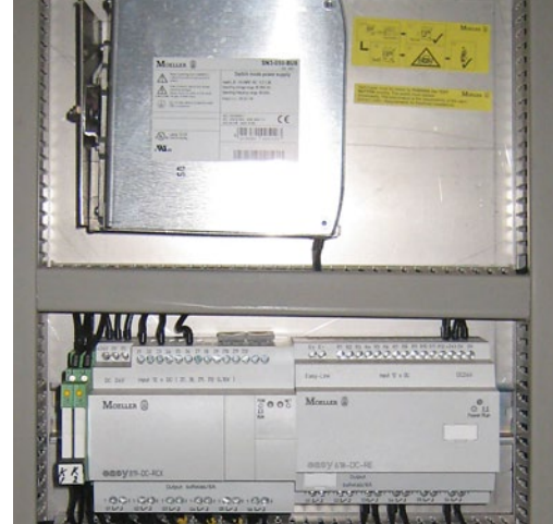
Ein Steuerrelais easy800 übernimmt in der Standardausführung des SpaceAqua LIV-Systems die Steuerung.
